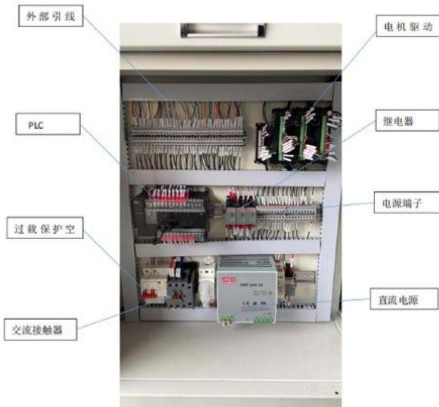
图8 电控板布局图
